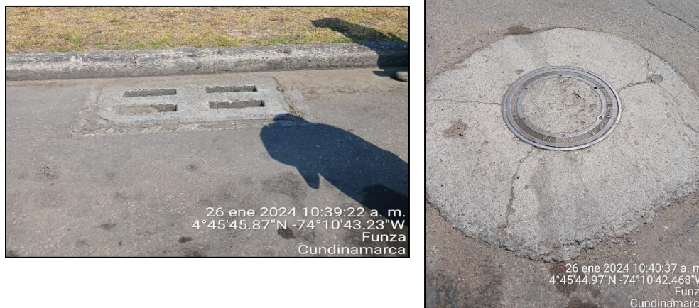
Ilustración 24. Sumideros y pozos de inspección
