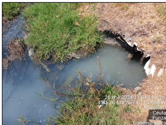
Ilustración 27. Descarga alcantarillado pluvial reservorio 4
