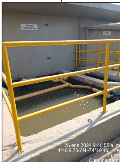
Ilustración 8. Tanque de decantación
