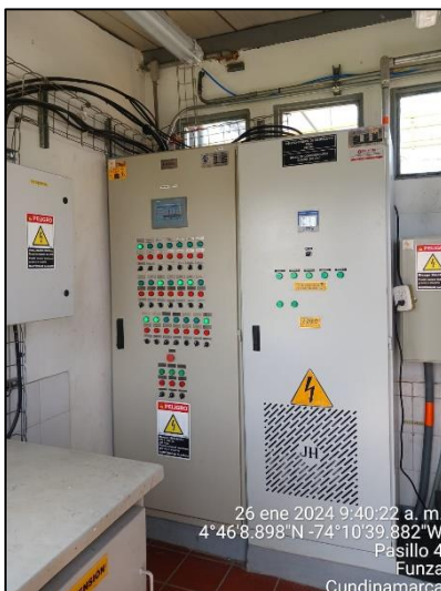
Ilustración 14. Tablero de control sistema de automatización
