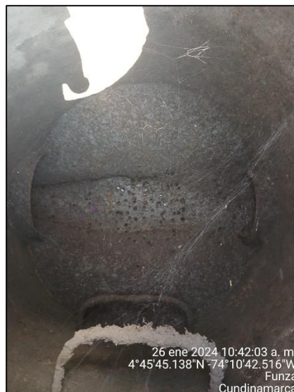
Ilustración 25. Pozos de alcantarillado pluvial secos
