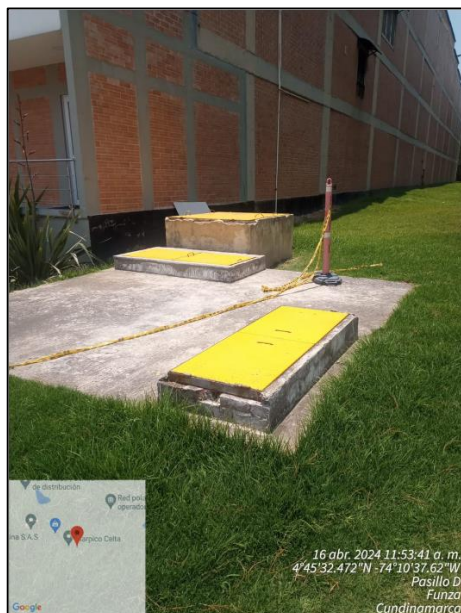
Ilustración 34. Estación elevadora de aguas residuales.
