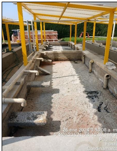
Ilustración 12. Lechos de secado
