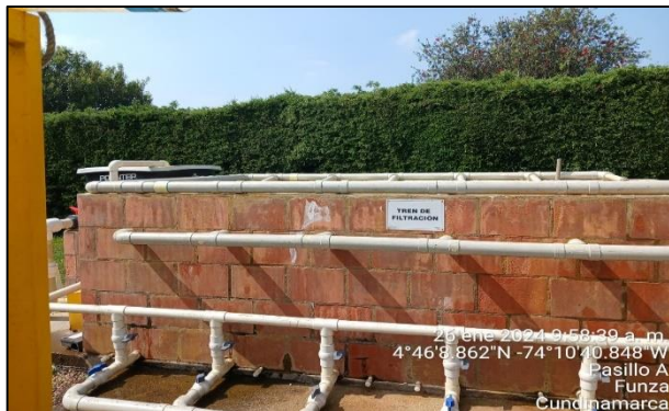
Ilustración 9. Sistema de filtración
