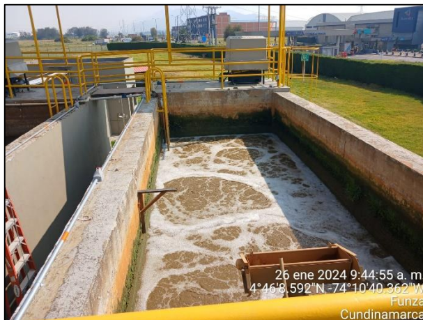
Ilustración 7. Reactores lodos activados
