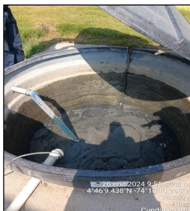
Ilustración 11. Espesadores de lodo
