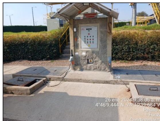
Ilustración 4. Tanque de almacenamiento y tablero de bombas
