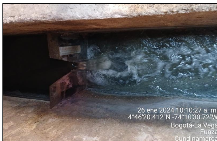
Ilustración 15. Canaleta de medición de caudal de ARnD
