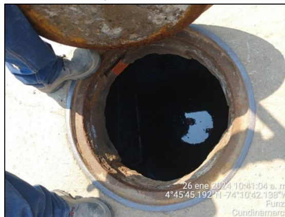
Ilustración 26. Pozos de alcantarillado pluvial con agua
